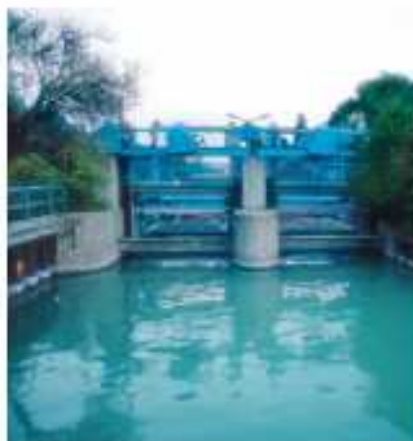
67.2. A Sió-csatorna zsilipjének* nyitásával és zárásával szabályozzák a Balaton vízszintjét
